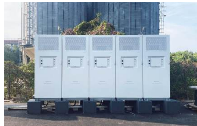
• 匈牙利 DH200Y 500kW/1160kWh 自发自用+光伏消纳
