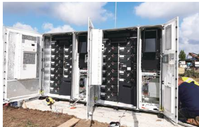
• 荷兰 DH200F 300kW/645kWh 动态扩容+光伏消纳+充电桩
